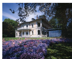
16. La Fondation de l'Hermitage, Lausanne © photo François Bertin
