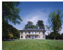
15. La Fondation de l'Hermitage, Lausanne © photo François Bertin
